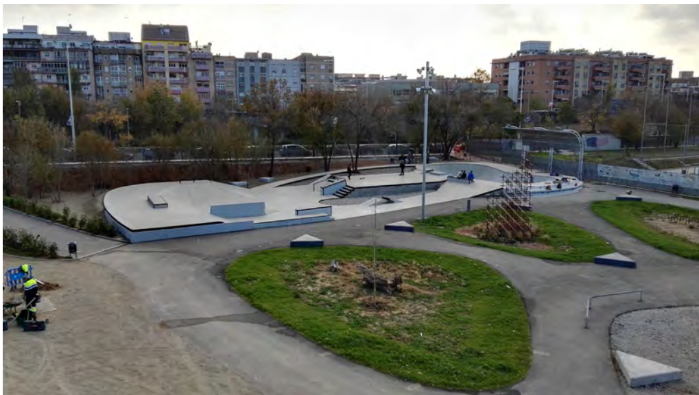
Proceso de construcción y lonas con relatogramas . Fotografías de Straddle3.
