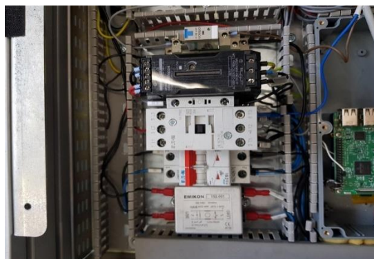
Il·lustració 163 - Dispositius per convertir la senyal de 220V AC a 24V DC
