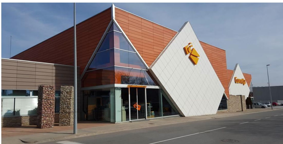
figura 17: El magatzem de Corretja S.L, vista façana, elaboració pròpia
