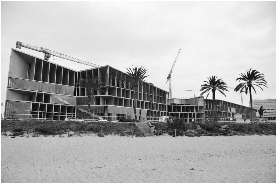
Figura 3. Platja de Can Pere Antoni amb el Palau de Congressos en construcció
