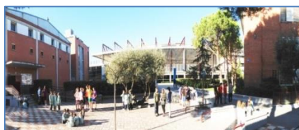
Imatge 7.2.1: Instal·lacions de l'escola
