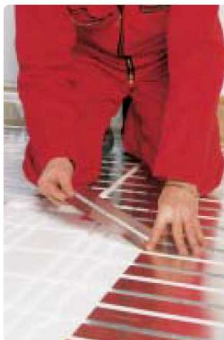
Figura 13. Detall d'instal·lació de diferents aplicacions dels difusors d'alumini
