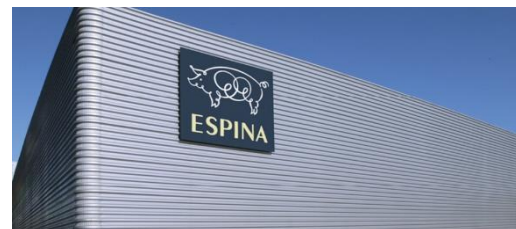
Nau d'Embotits Espina ubicada al PAE i construïda l'any 2002
