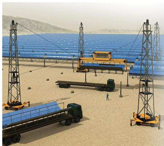
Figura 6.2.2. Simulación de instalación de robot de cables
