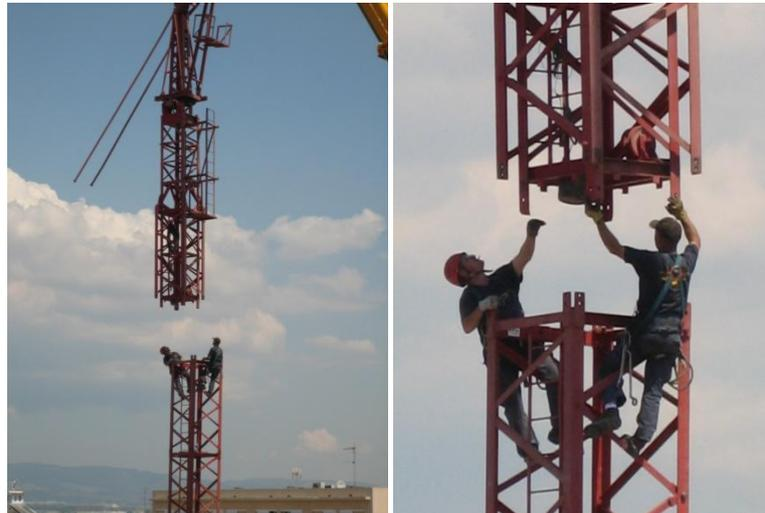
Fig. 3.; Unión de dos tramos de la torre.
