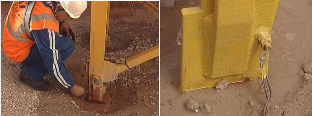
Fig. 11.; Control de la toma de tierra de la torre grúa.
