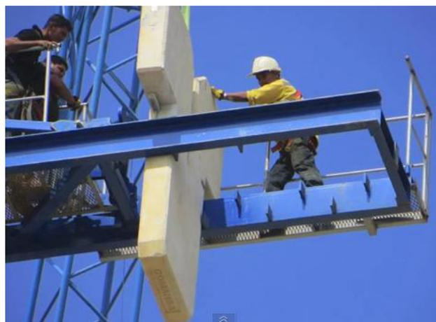
Fig. 4.; Colocación de los pesos en la contra pluma.
