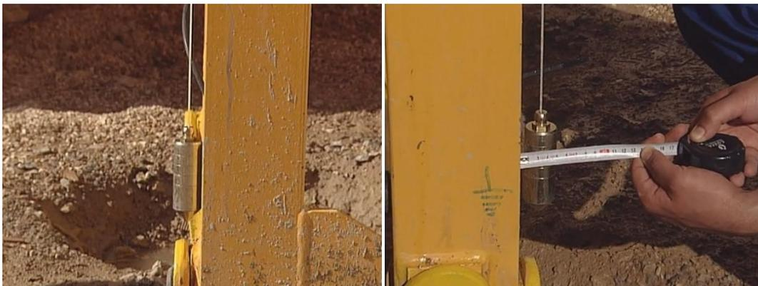
Fig. 10.; Control del desplome de la torre grúa.
