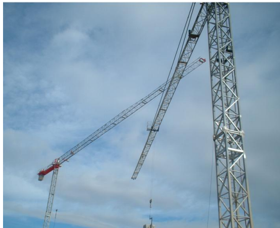
Fig. 4. Cruzamiento de torres grúas.
