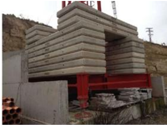
Fig. 16. Lastre de una torre grúa.
