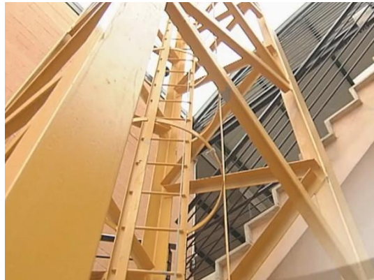
Fig. 11. Escaleras interiores de una torre grúa.
