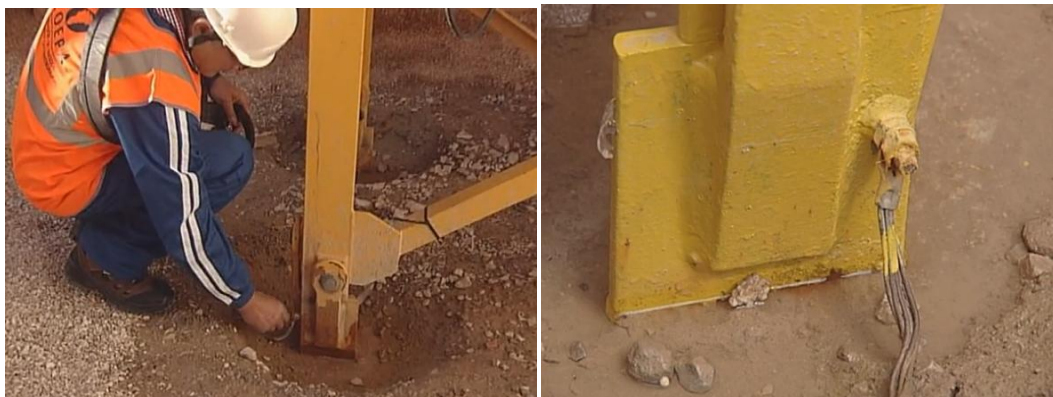
Fig. 10. Control de la toma de tierra.
