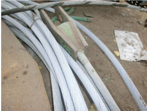
Fig. 12. Cable tensor de la pluma.
