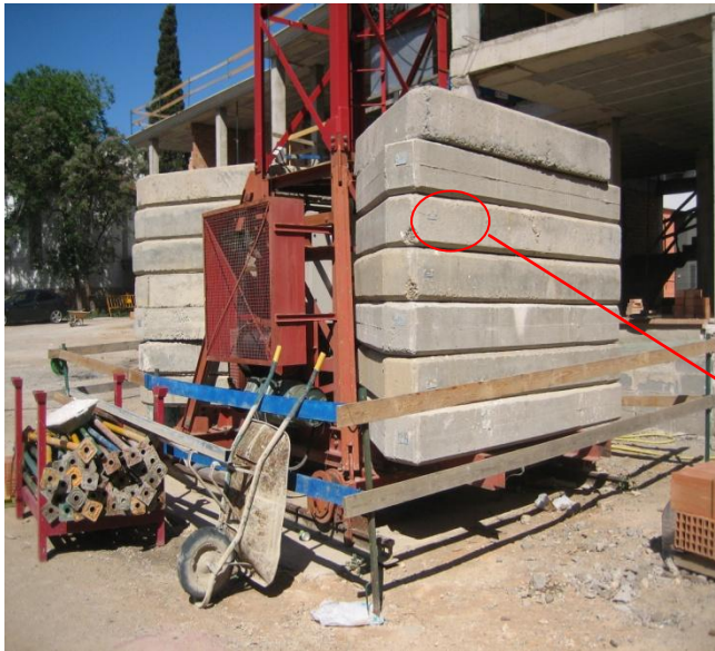
Fig. 25. Bloques de la base
