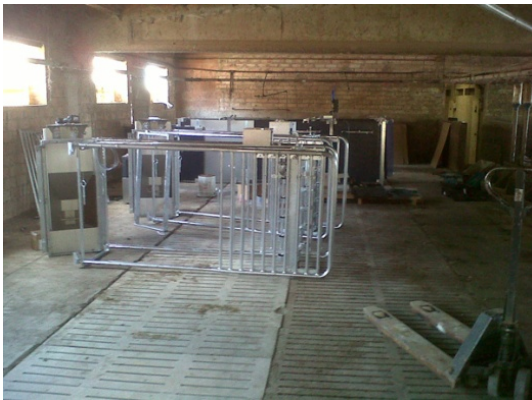
Foto 17: Instal·lació de les màquines d'alimentació electrònica.
