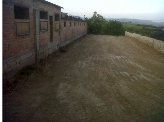
Foto 2: Terreny pla i a punt per iniciar les obres.
