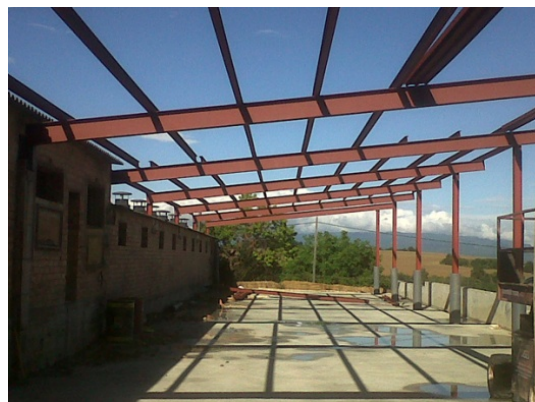
Foto 6: Col·locació de l'estructura metàl·lica per a la coberta de la nau.
