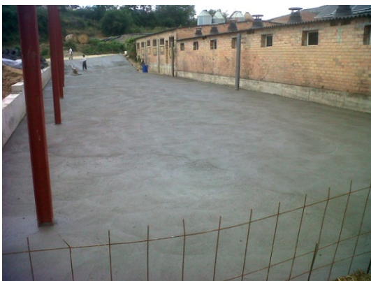
Foto5: Paviment acabat de la zona de repòs amb palla de la nau de gestació. Armat per al mur de formigó de la cara Sud.
