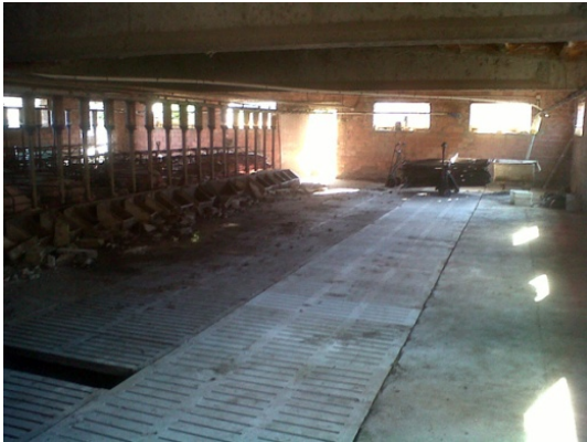
Foto 15: Procés de buidatge de la nau de gestació antiga. S'han tret dos rengles de gàbies i canviat un rengle d'engraellats.
