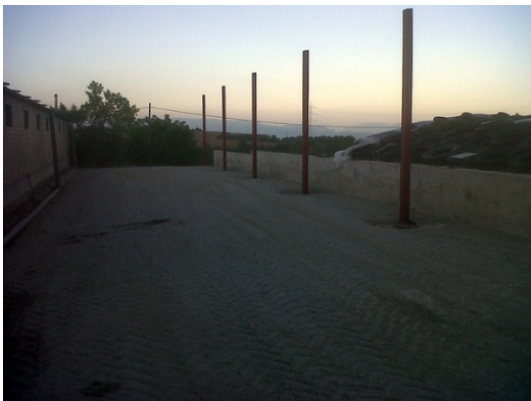
Foto3: Fonamentació per a les sabates i posterior col·locació dels pilars.
