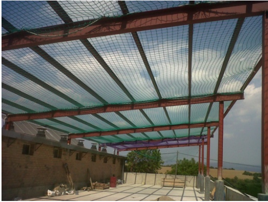
Foto7: Mesures de seguretat preses per a la col·locació de la coberta.
