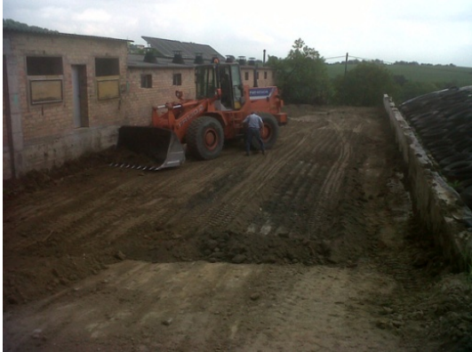
Foto 1: Tasques d'explanació del terreny i moviments de terres.
