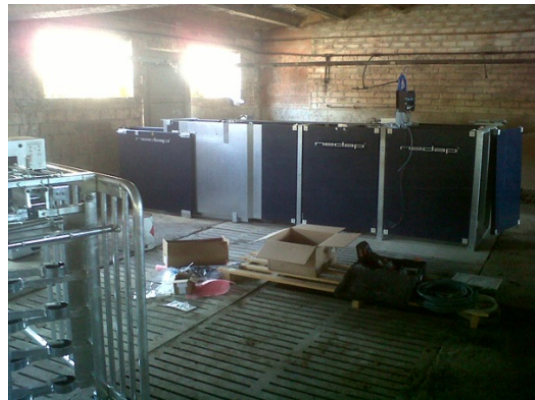
Foto 18: Instal·lació de la unitat separadora Nedap-Velos.
