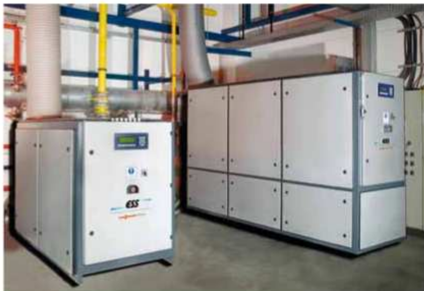
Fig.35: Sincrogenerador y batería de arranque seleccionados. Fuente Viessmann.
