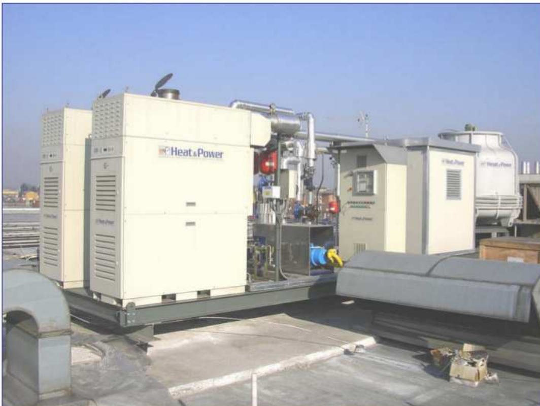
Fig.34: Instalación similar a la planteada. Fuente Ikea en Milán (Italia).
